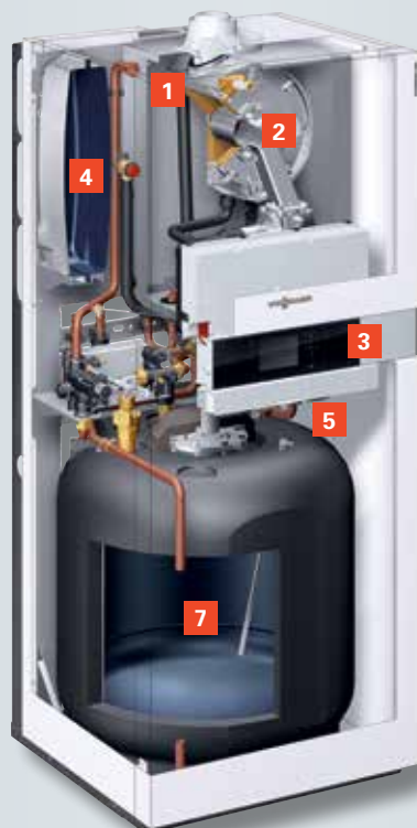
Vitodens 222-F (typ B2TB) se smaltovaným nabíjecím zásobníkem.
