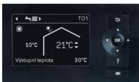
Displej regulace tepelného čerpadla Vitotronic 200.
